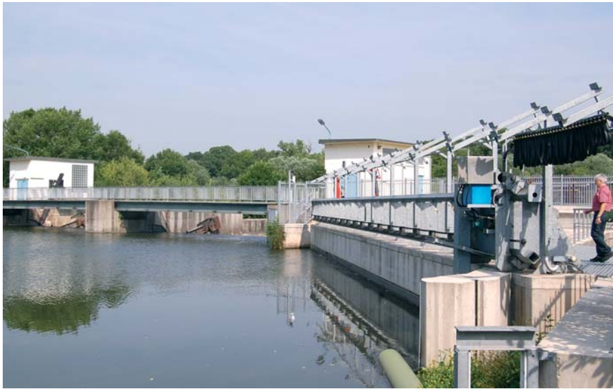
Durch moderne Fischschutz- und Fischabstiegssysteme können Fischschäden an Wasserkraftanlagen deutlich reduziert werden. Die Funktionsfähigkeit setzt jedoch eine detaillierte Planung nach ingenieurbioologischen Kriterien voraus. Das Foto zeigt ein Leitreechen-Bypass-System nach Ebel, Gluch & Kehl (2001) an der Wasserkraftanlage Plane-na / Saale Foto: Sachverständigenbüro Dr. Ebel
